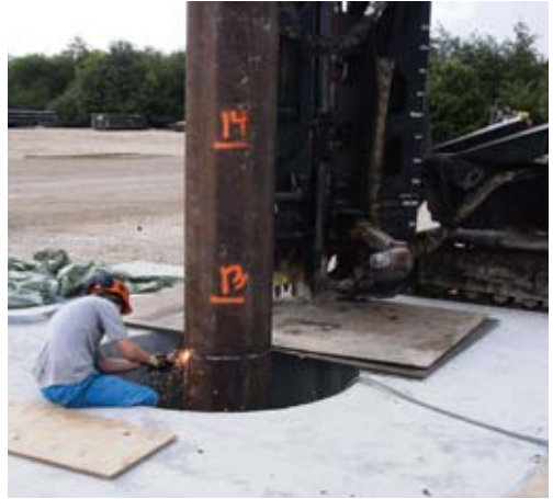
Kapning av ledrör. Det första av många foderrör som kommer att sänkas i Karlebo.
